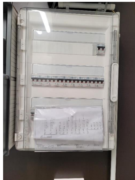
zekeringsbord elektriciteit
