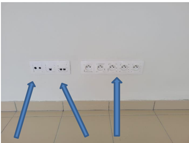
aansluiting televisie, internet en gewone stopcontacten
