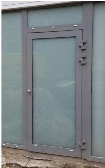
Toegangsdeur naar huisvuillokaal
