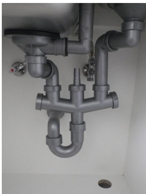
Aansluitingen vaatwasmachine
