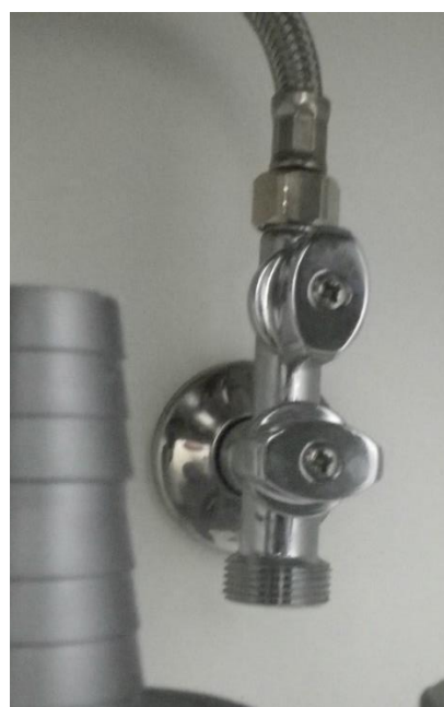
Aansluitingen vaatwasmachine
