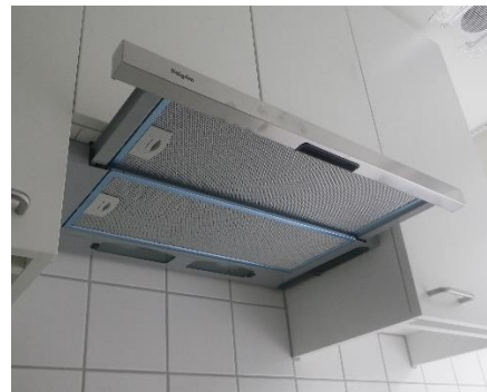
Dampkap - metalen filters
