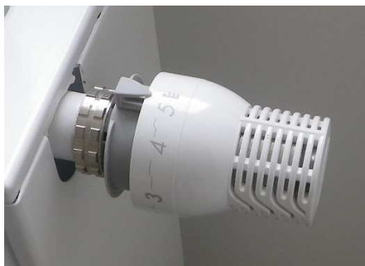
Thermostatische radiatorkraan
