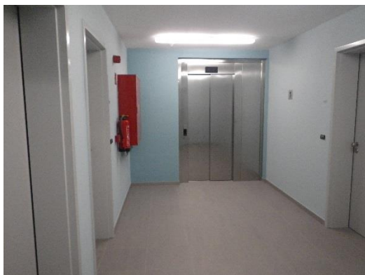
Gang met lift en brandblusser/-haspel
