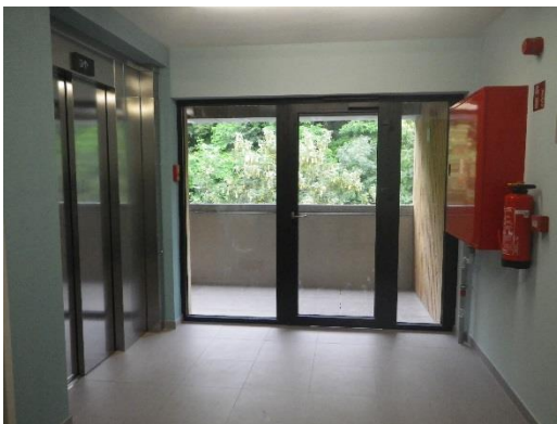
Gang met lift en brandblusser/-haspel
