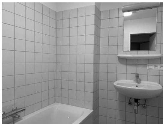
Badkamer eerste verdieping
