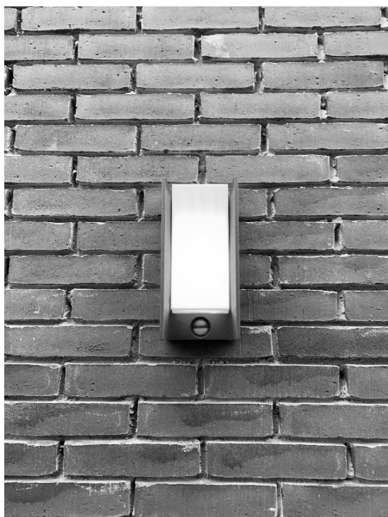
Buitenverlichting met bewegingssensor (Zijgevel)
