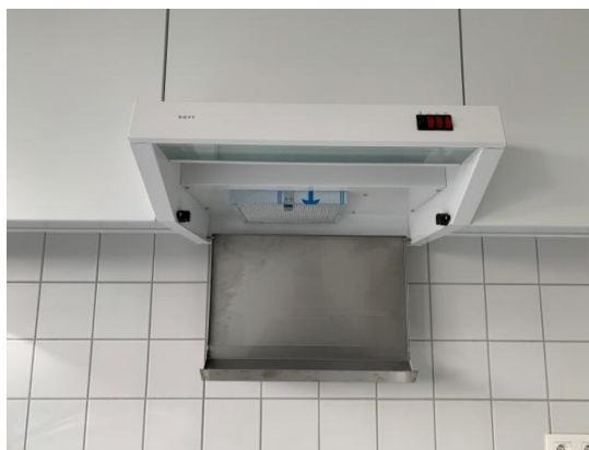
Dampkap, geopend (om filter te verwijderen)
