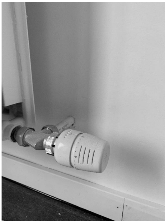
Thermostatische radiatorkraan
