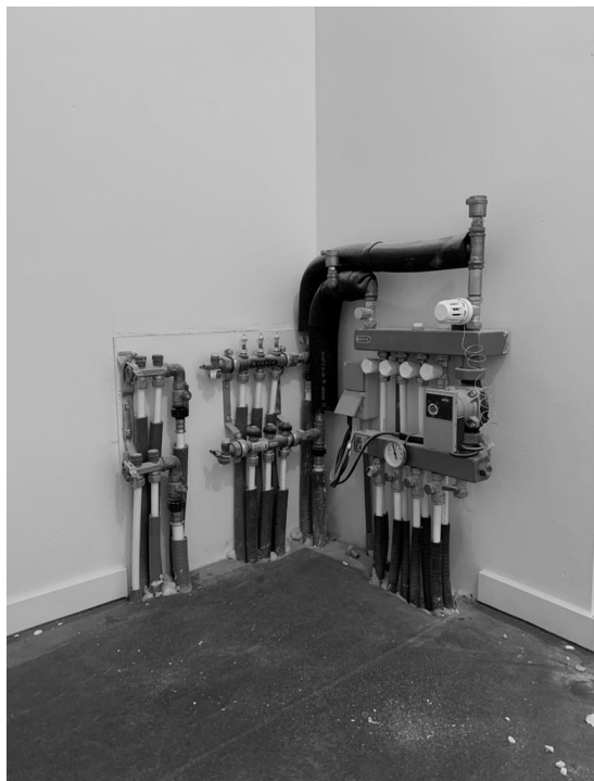
Collector voor vloerverwarming in de kast in de nachthal
