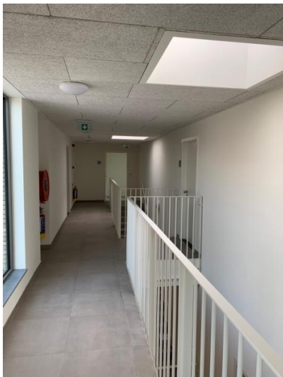
Centrale gang (derde verdieping)
