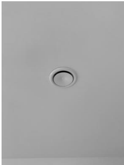
Ventiel voor toevoer van lucht
