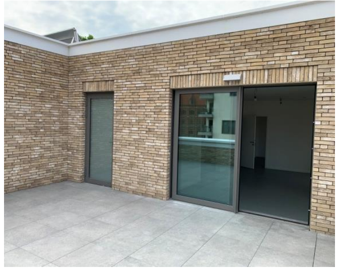
Terras met tegels op tegeldrager en stenen borstwering
