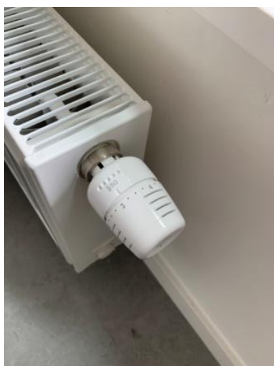
Thermostatische radiatorkraan
