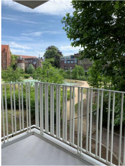
Terras met betonnen vloer en stalen borstwering
