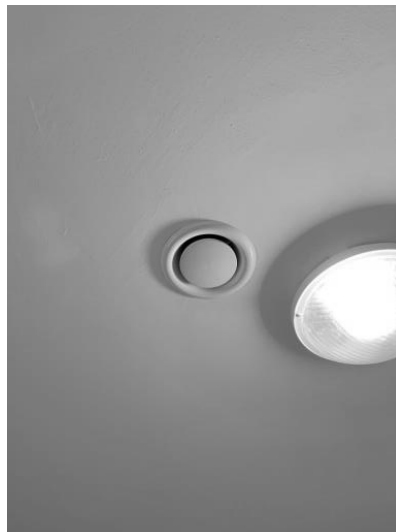
Ventiel voor afvoer van lucht
