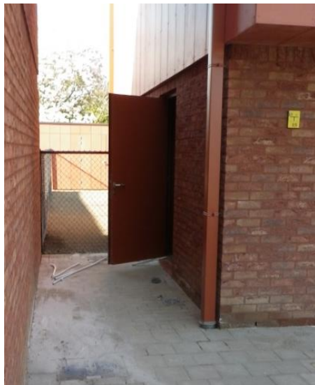
Toegang tot meterlokaal
