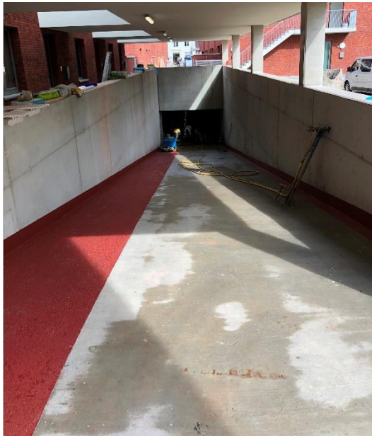
inrit naar de ondergrondse parking
