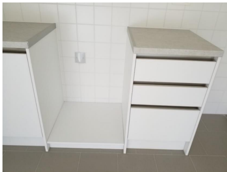
nis voor het fornuis met de verplaatsbare sokkel
