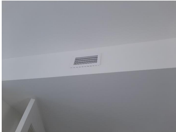
ventilatioerooster voor toevoer verse lucht
