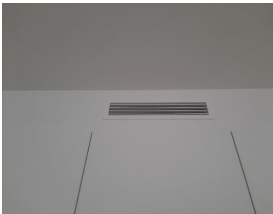
uitblaasrooster boven de keukenkasten
