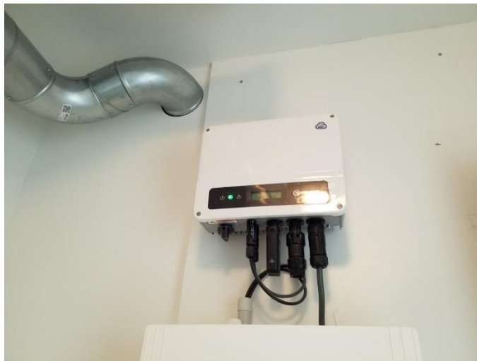
omvormer zonnepanelen
