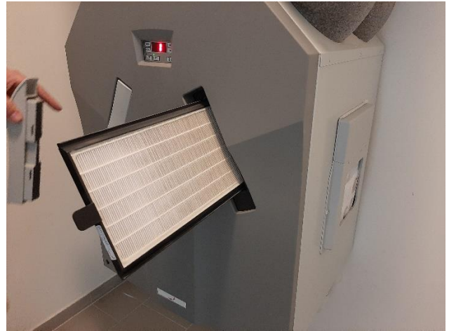
filters, deze dient u om de 3 maanden te reinigen
