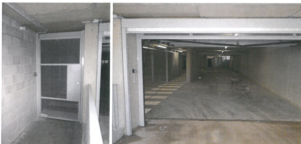
Deur naar garage
