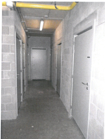
Bergplaatsen in kelder
