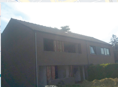
Seringenlaan in Oud-Heverlee Aantal woningen: 10 huizen Renovatie*
