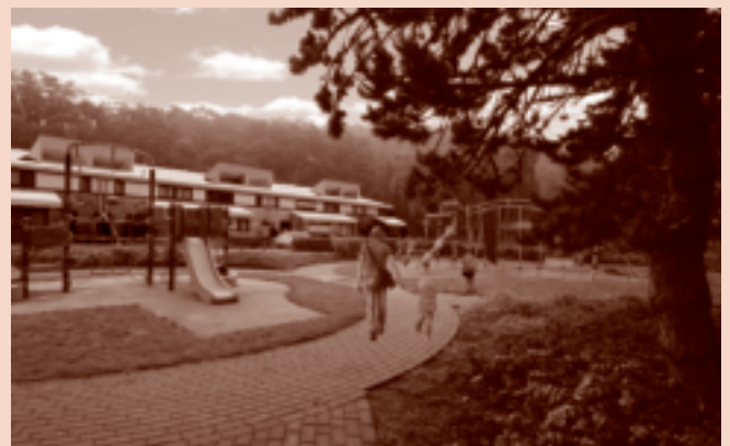
Ir. Architect Rob Mols Wilgenhof/Hulsberg, Kessel-Lo renovatie van 28 woningen.
