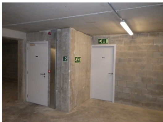
Aanduiding nooduitgang in garage op niveau -2 onder Brusselsestraat 195
