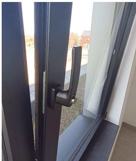
Stand van de raamkruk voor raam in kipstand
