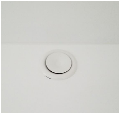
Ventiel voor ventilatie
