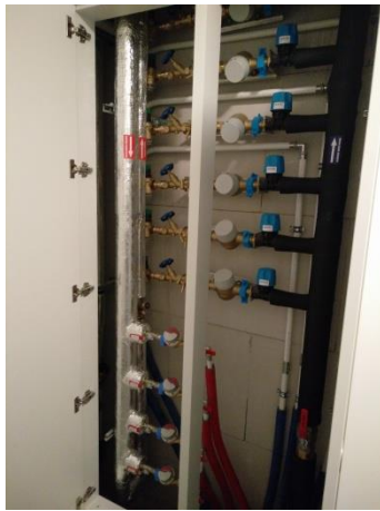
Kast met meters van koud en warm water
