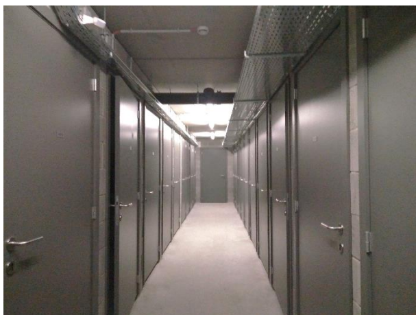
Gang met toegangen tot kelderbergingen
