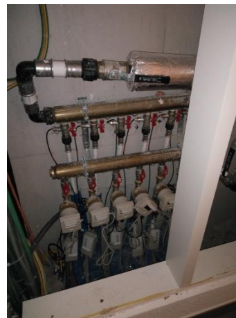
Koudwatermeter en warmtemeters voor warm water en centrale verwarming
