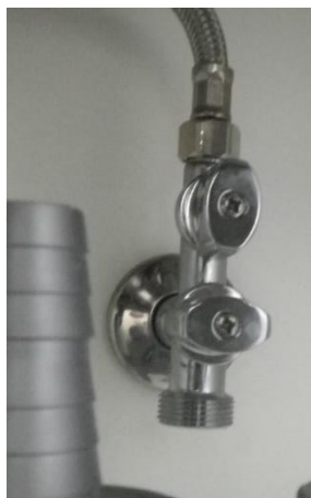
Aansluitingen vaatwasmachine
