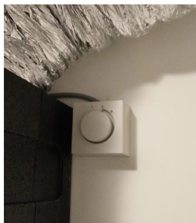
Schakelaar met 4 standen
