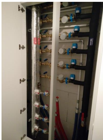
Koudwatermeter en warmtemeters voor warm water en centrale verwarming
