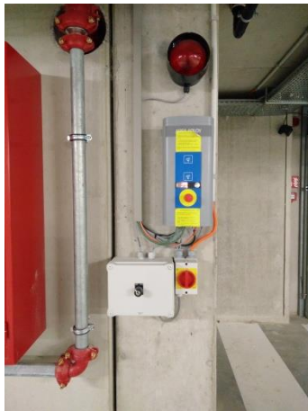
Bedieningspaneel garagepoort
