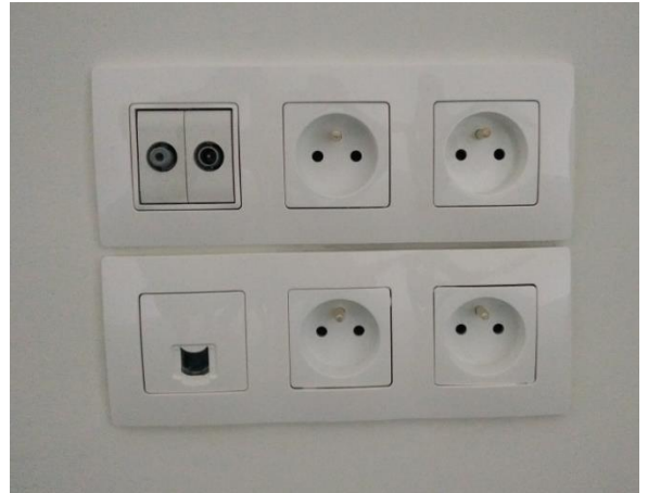
Boven: aansluiting televisie en satelliet
