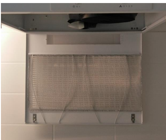
Dampkap - metalen vetfilter
