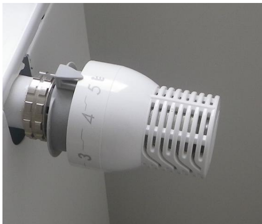
Thermostatische radiatorkraan
