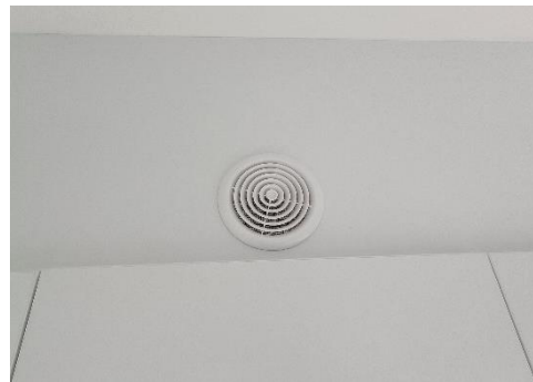
Uitblaasrooster boven de keukenkasten
