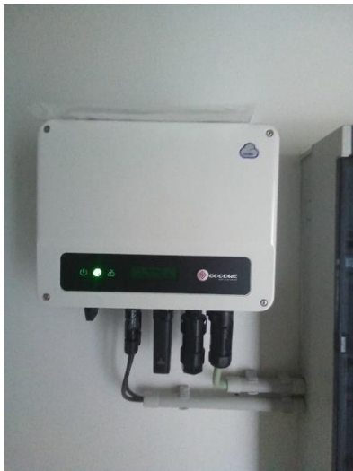
Omvormer zonnepanelen
