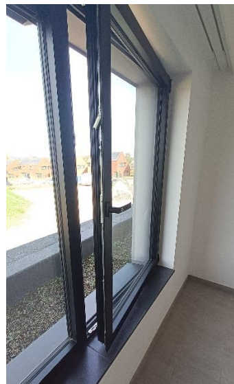
Stand van de raamkruk voor raam in draaistand
