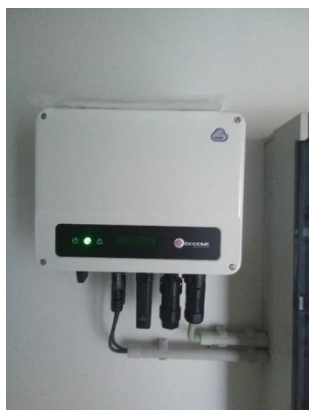
Omvormer zonnepanelen
