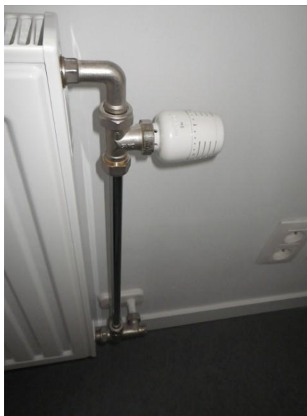
Thermostatische radiatorkraan
