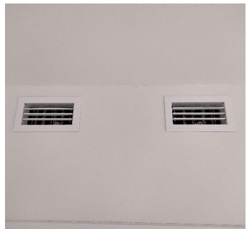
Inblaas werp ventielen voor efficiënte verluchting.
