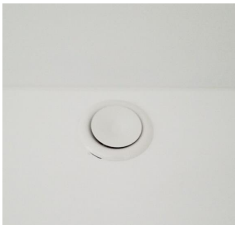
Ventiel voor ventilatie -
