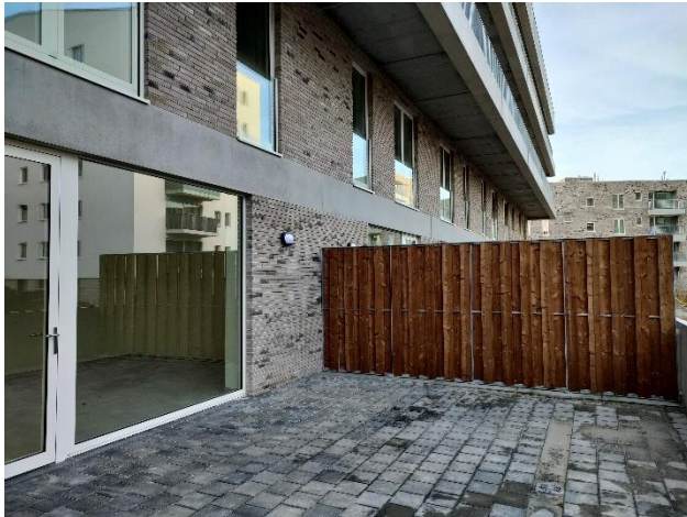
Terras - geklinkerd terras met houten en betonnen borstwering
