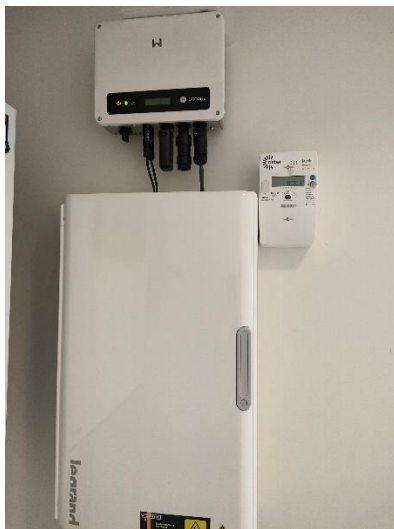
Omvormer zonnepanelen
