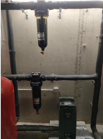
Filters regenwater recuperatie Watertellers algemene delen.
