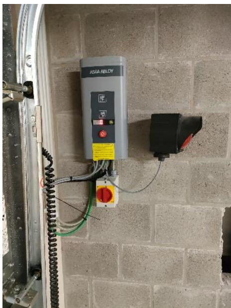
Bedieningspaneel garagepoort
