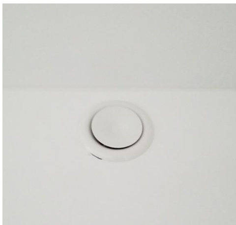
Ventiel voor ventilatie -
