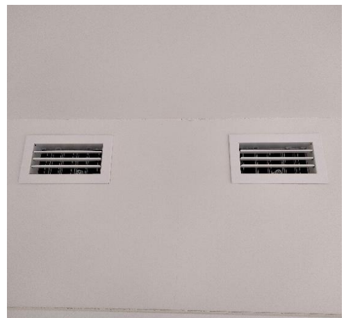
Inblaas werp ventielen voor efficiënte verluchting.
