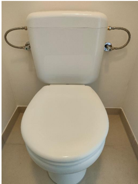
Toilet met dubbele aansluiting van regenwater en stadwater.
