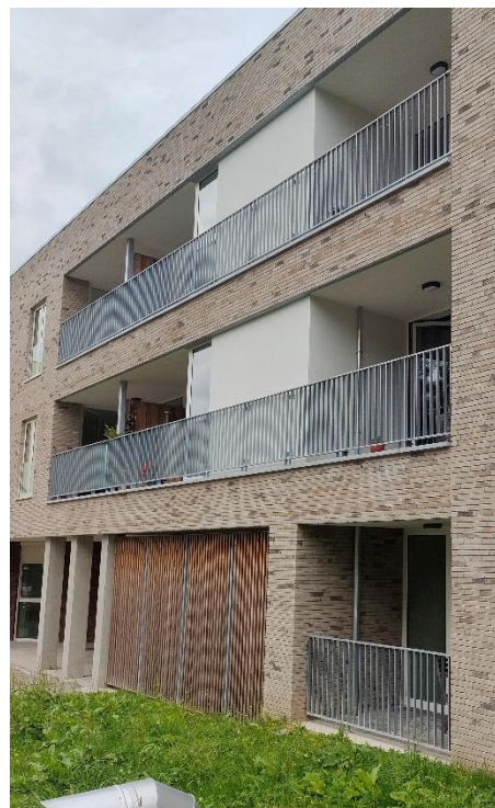
Terras - betonklinkers met metalen betonnen borstwering op het gelijkvloers
