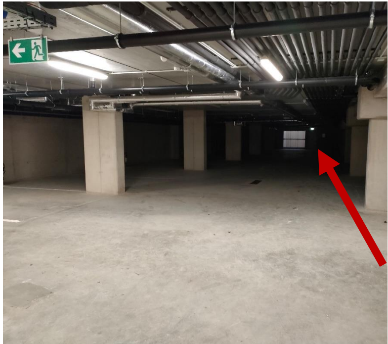
Parkeergarage met aparte toegang voor externe huurders en/of nooduitgang;
