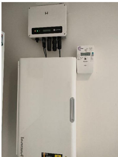
Omvormer zonnepanelen
