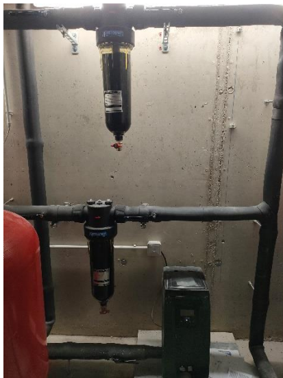
Filters regenwater recuperatie
