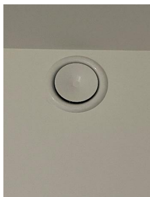
Ventiel voor toevoer van lucht
