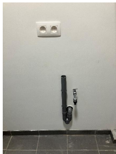
Aansluitpunt voor wasmachine en droogkast
