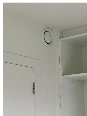
Ventiel voor afvoer van lucht
